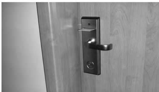
Obr. 78 Kartový snímač pro otevírání dveří zabudovaný v kování kliky
