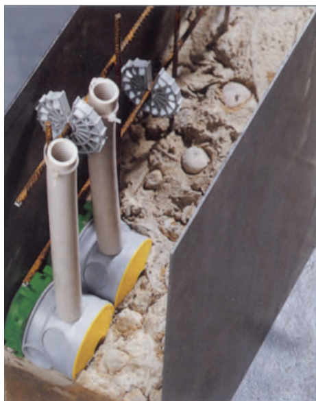
Obr. 9 Krabice a trubky v monolitickém betonu
