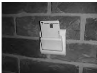
Obr. 79 Kartový spínač ve společném rámečku s klasickým spínačem a namontovaný kartový spínač
