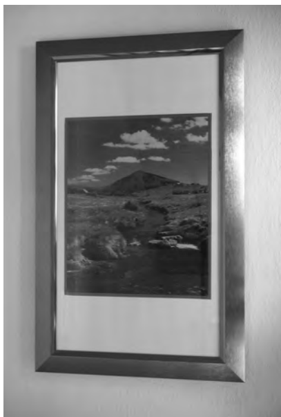
Obr. 33 Rozváděč se dvířky ve tvaru proskleného rámu pro obrázek
