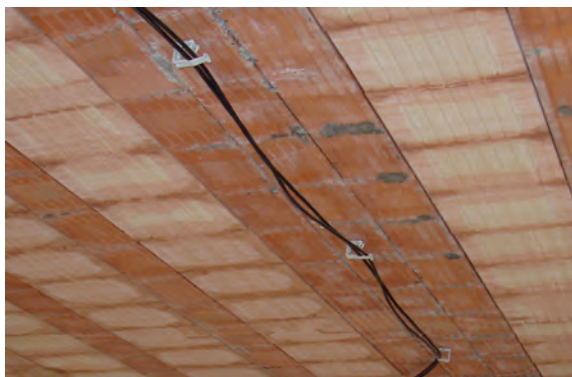
Obr. 12 Vkládání kabelů do závěsných přichytek
